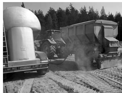
Fot. 1. Załadunek spoiwa Terramix F do rozsypywacza Fot. S. Piasecki
