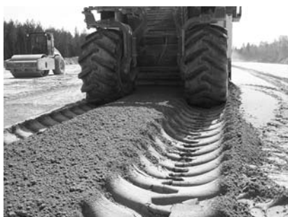
Fot. 2. Mieszanie spoiwa Terramix F z gruntem i spoiwo tuż po przemieszaniu
