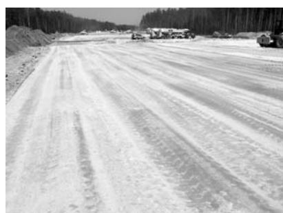
Fot. 3. Grunt po wyrównaniu i wałowaniu. Efekt stabilizacji spoiwem Terramix F
