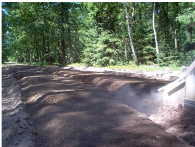
Fot. 2. Grunt po przemieszaniu ze spoiwem
