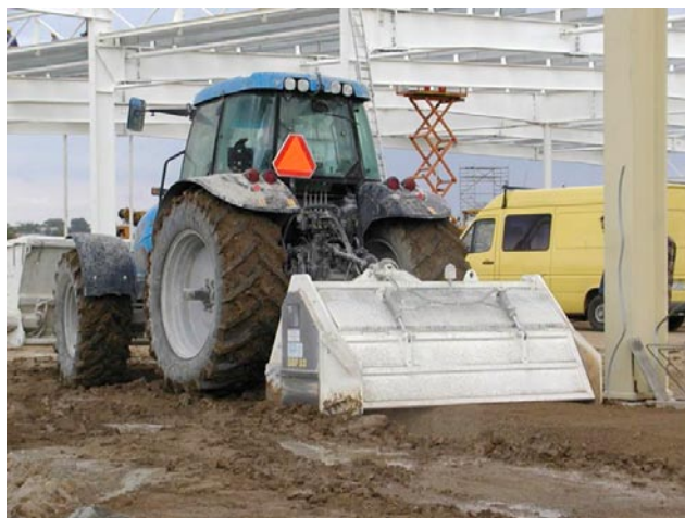
Fot. 3. Stabilizacja gruntu w hali
