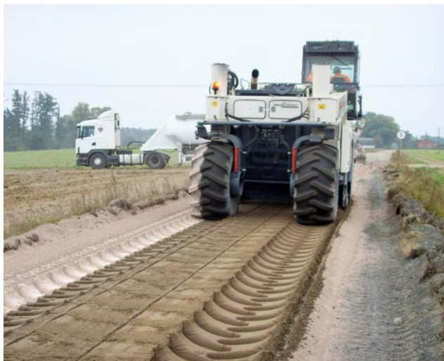
Fot. 4. Mieszanie spoiwa z gruntem za pomocą recyklera
